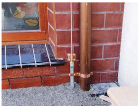
Ввод токоотвода в землю с подключением к металлической трубе и использованием контрольного зажима
