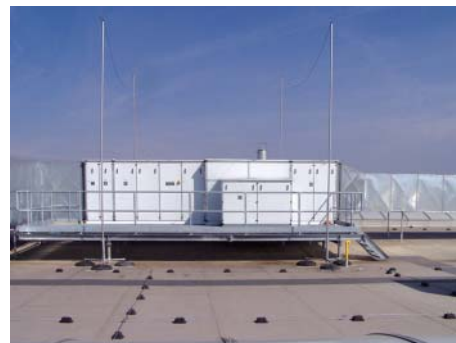
Система отдельностоящих мачт, защищающая блоки промышленных кондиционеров
