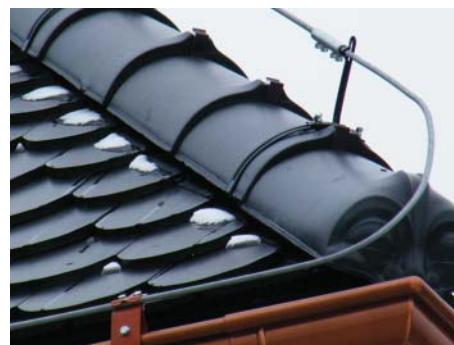
Токоотвод, смонтированный на коньке кровли с помощью конькового держателя
