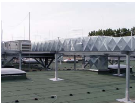
Система отдельностоящих мачт, защищающая воздуховоды системы кондиционирования
